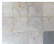
Marbre gris clair, escalier // à conserver
