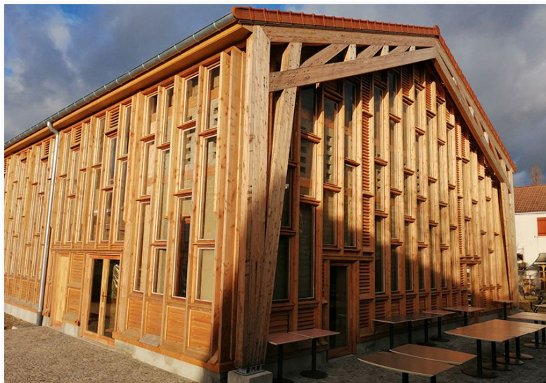
Menuiseries de réemploi en façade
