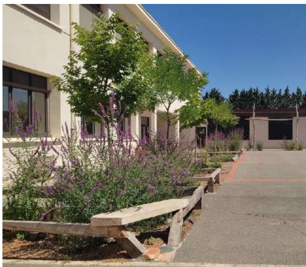
Massif de vivaces et plantation d'arbres après décroûtage, sans bordure pour une collecte des eaux de ruissellement. École élémentaire de Rieux-Volvestre (31). MOE : EM Paysage
