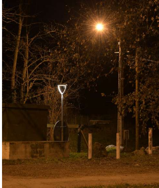
Parking de la RNR : l'éclairage LED n'a pas d'utilité. Le lampadaire SHP est trop puissant. Extrait du rapport Athena-Lum.
