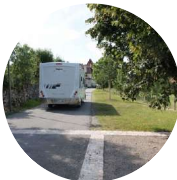
Stationnement en mélange terre- pierre - Orniac (46) © Palimpseste
