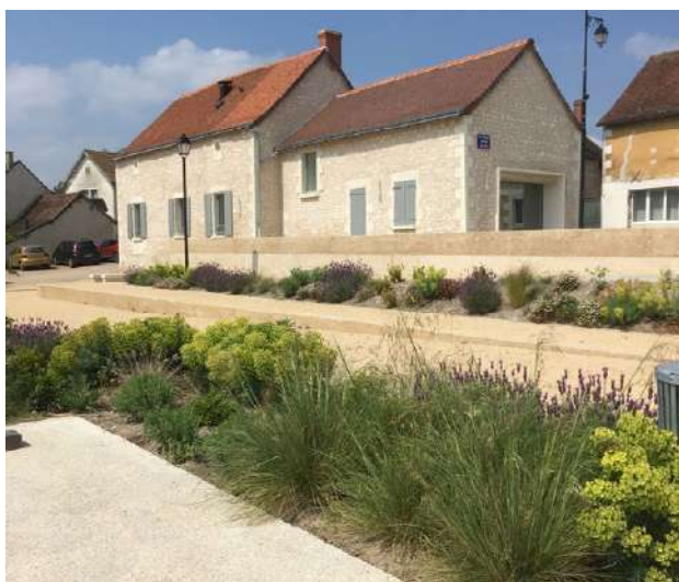
Cœur de village d'Antigny-le-Tillac (37) réalisé en béton de site* . MOE : © Bauchet & de La Bouvrie architectes, De Long en Large paysagistes.
