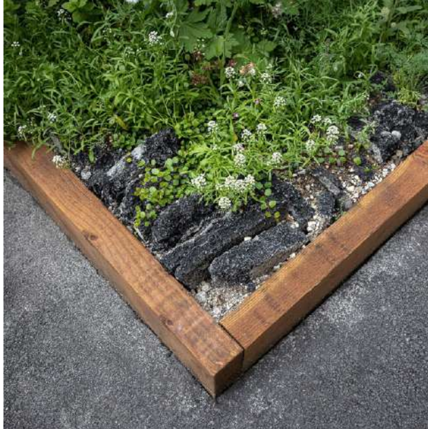
Végétalisation d'une cour en recyclant sur site la couche d'enrobé décroûté. MOE : Wagon Landscaping © Yann Monel
