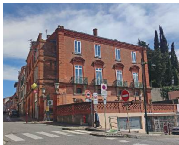
Façade de la maison Pince sur l'espace public
