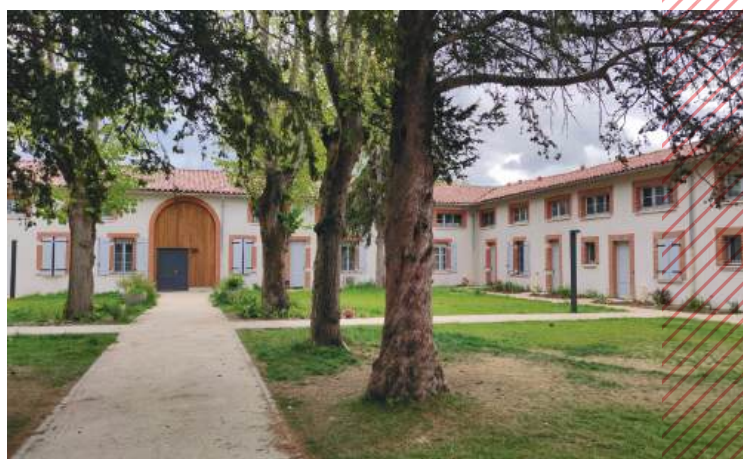
Un grand nombre de logements donnent sur la cour intérieure
