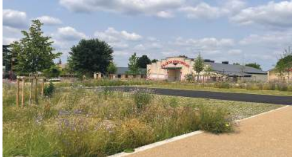
Après : 100 % perméable avec des espaces de pleine terre (arbres et prairie naturelle), du cheminement en stabilisé, des dalles alvéolaires végétalisées, et un enrobé drainant © Tout est Paysage
