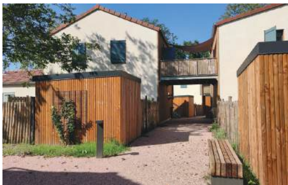
La desserte des logements neufs est essentiellement piétonne.
