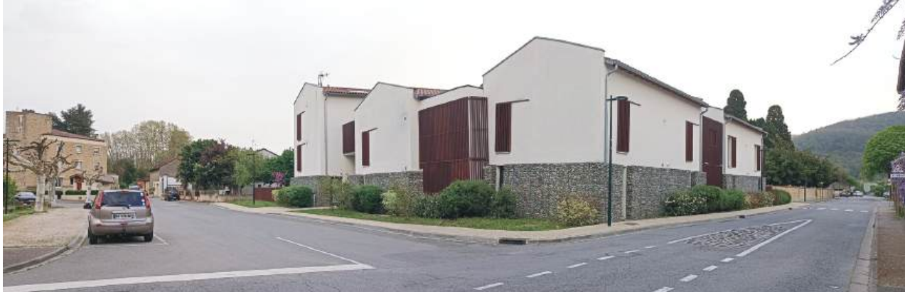
Les façades nord-ouest le long de la rue des Jardins et sud-ouest le long de l'avenue du 11-Novembre-1918, accompagnée d'une végétalisation en pieds de murs
