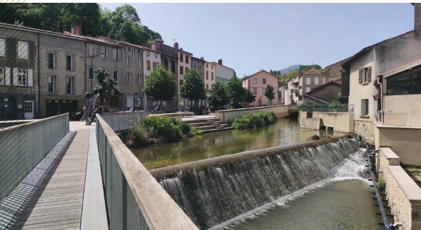
Vue depuis la passerelle
