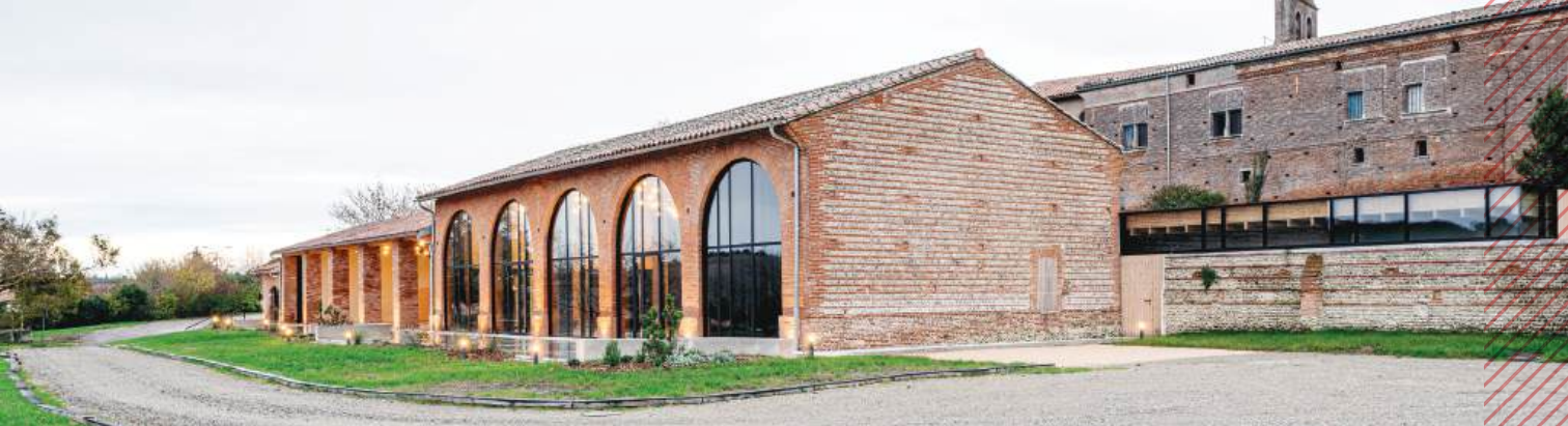
Vue du corps de bâtiment rénové et de l'extension émergeant au-dessus du mur d'enceinte © Antoine Huot, OECO Architectes
