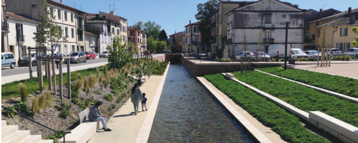
Pamiers (09) / Cours Joseph Rambaud , découverte d'une partie du canal qui était recouvert par un parking, création d'espaces publics, désimperméabilisation, mise en lumière des anciens ouvrages de ponts, livraison 2023 / Conception : Atelier Gama
