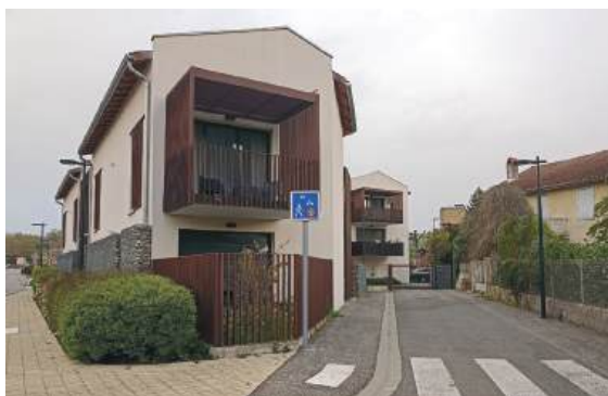
Les balcons orientés sud-est offrent une vue sur les Pyrénées
