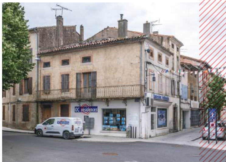
État initial du bâti © EPFO
