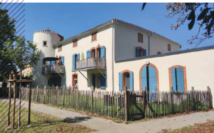
Façade arrière côté parc de la maison de maître réhabilitée en 6 logements. Chacun dispose d'un espace extérieur, jardinet ou balcon
