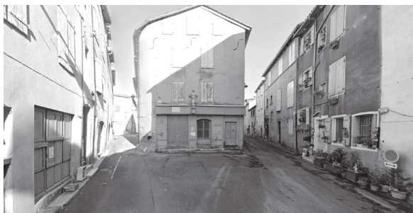
Avant : des logements et commerces vacants et vétustes, des ruelles étroites
