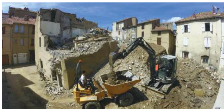
Phase de démolition de l'îlot vétuste © Atelier-A Architecture Ville et Lumière
