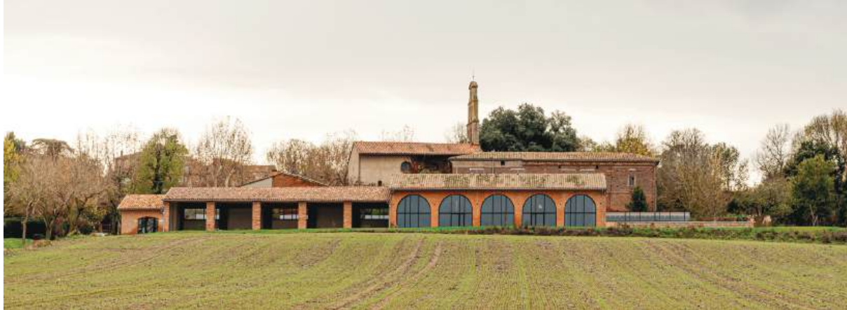
Aureville (31), Transformation d'anciens bâtiments agricoles en halle et salle des fêtes Conception : OECO Architectes (31), Emacoustic (31), Otès (31), 2023 © Antoine Huot
