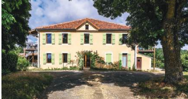
La façade est conservée à l'identique, avec ses encadrements en pierre de taille, son fronton, sa génoise © Marie Pirot
