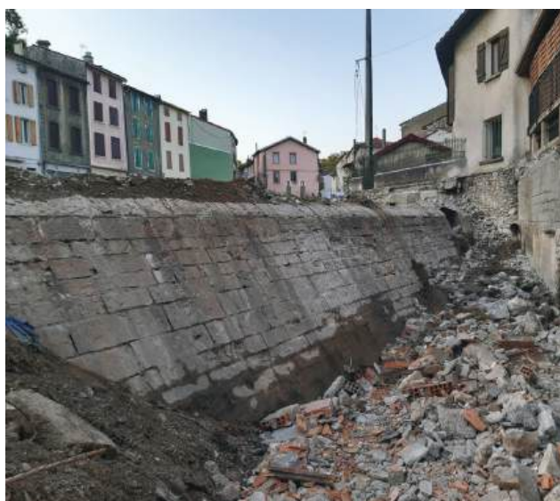
Mise à nu d'une chaussée XVIII e avant travaux, valorisée en « cascade » dans le projet © Architecture et Paysage
