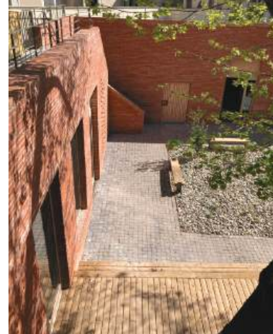
Construction neuve, en rez-de-chaussée sur cour © Bellevilles
