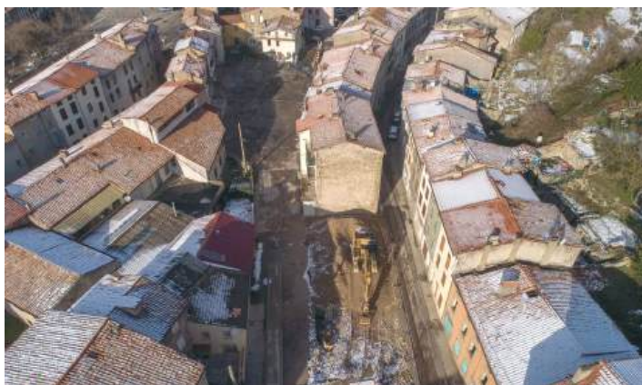
Démolition des 8 immeubles en cours © Ville de Lavelanet
