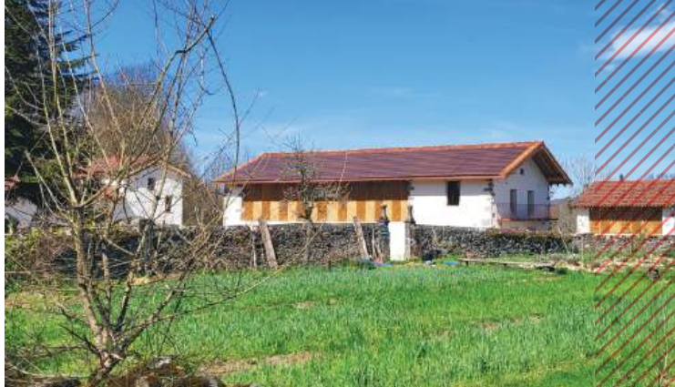
Couverture en tuiles et panneaux photovoltaïques de teinte rouge, claustra en bois © Christophe Broichot
