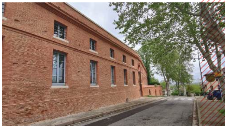
Le mur en briques du château valorise l'espace public et la rue Jane-Dieulafoy
