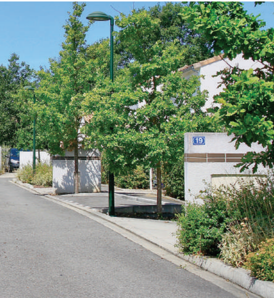
Villaudric / Murets maçonnés supports de coffrets techniques.
