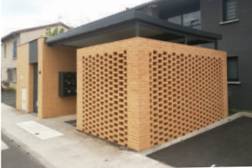
Buzet-sur-Tarn / Locaux poubelles et vélos.
