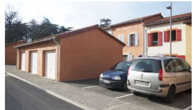
Saint-Sulpice-sur-Lèze / Garages d'architecture traditionnelle dissociés des logements.
