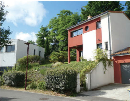
Pechabou / Absence de clôture.
