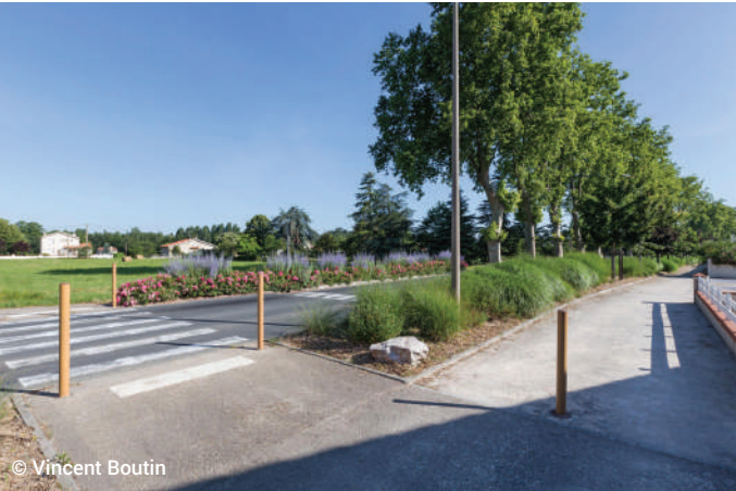
Soual / Requalification d’une ancienne voie départementale en boulevard urbain Conception : R. Gaxieu, BET.
