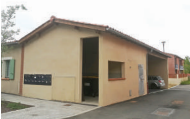
Pechbonnieu / Regroupement d’éléments techniques (dont du stationnement).
