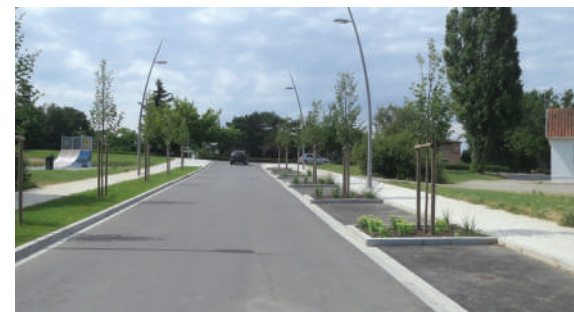
Escalquens / Voie primaire avec stationnement d'un côté.
