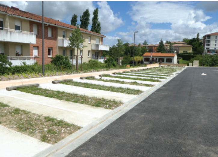
Nailloux / Stationnement béton et mélange terre-pierre.
