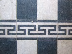
Carreaux granito noir et blanc en damier // à conserver
